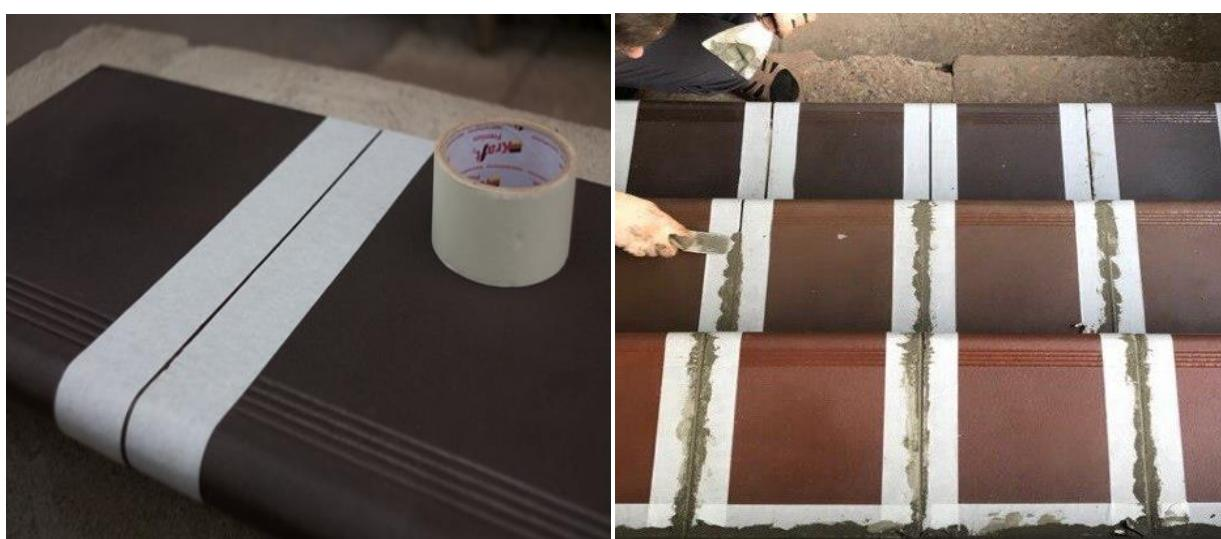
4. Перед монтажом фронтальных всех типов изделий (фронтальные, угловые ступени, базовые плитки, подступенки) рекомендуется наклеить малярный скотч по периметру изделия, для предотвращения попадания на изделия затирки и клея. По возможности, лицевая часть также должна быть закрыта, например пленкой.
